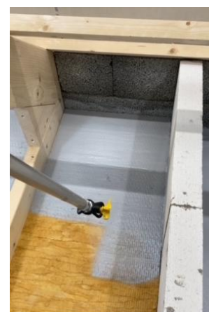
Membran påføres, minimum 0,5 mm tør Dampspærre
