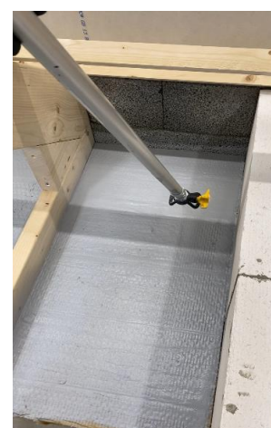
Membran påføres, to lag af minimum 0,5 mm pr. lag. tør Radonspærre
